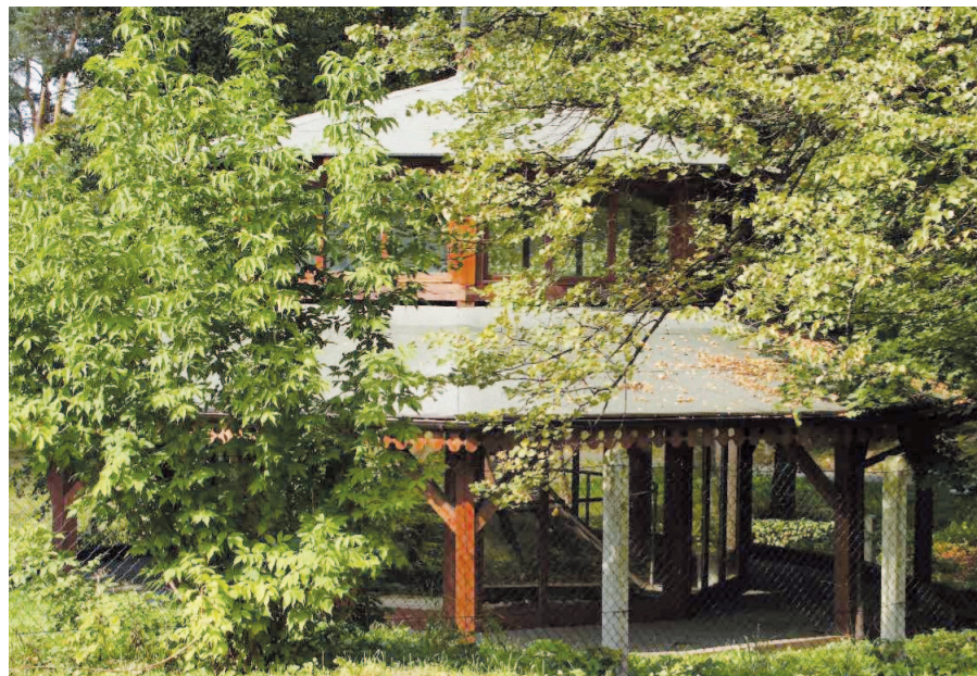
Ujęcie wody „Zdrój Główny”.
