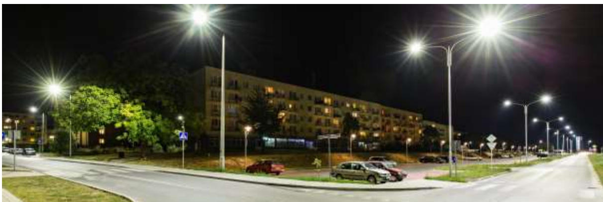
Fot. Archiwum UM Busko-Zdrój – „Projekt Sowa” oświetlenie uliczne.
