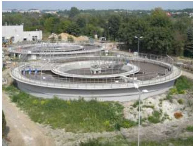
Fot. Archiwum MPGK – Oczyszczalnia ścieków w Siesławicach.
