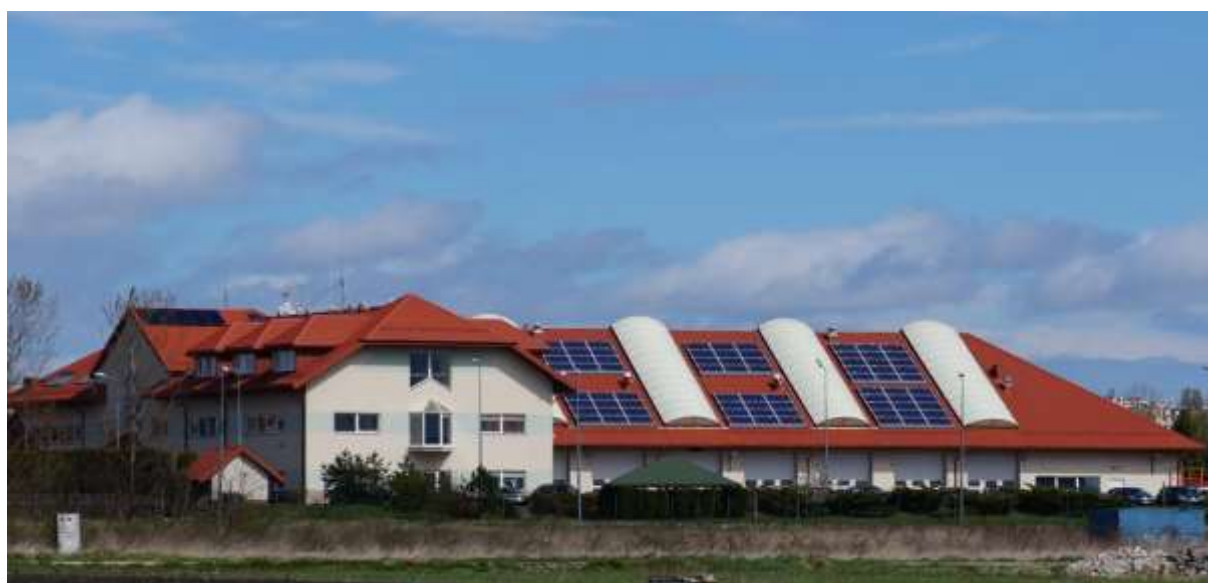
Fot. Archiwum UM Busko-Zdrój – instalacja solarna na budynku użyteczności publicznej.
