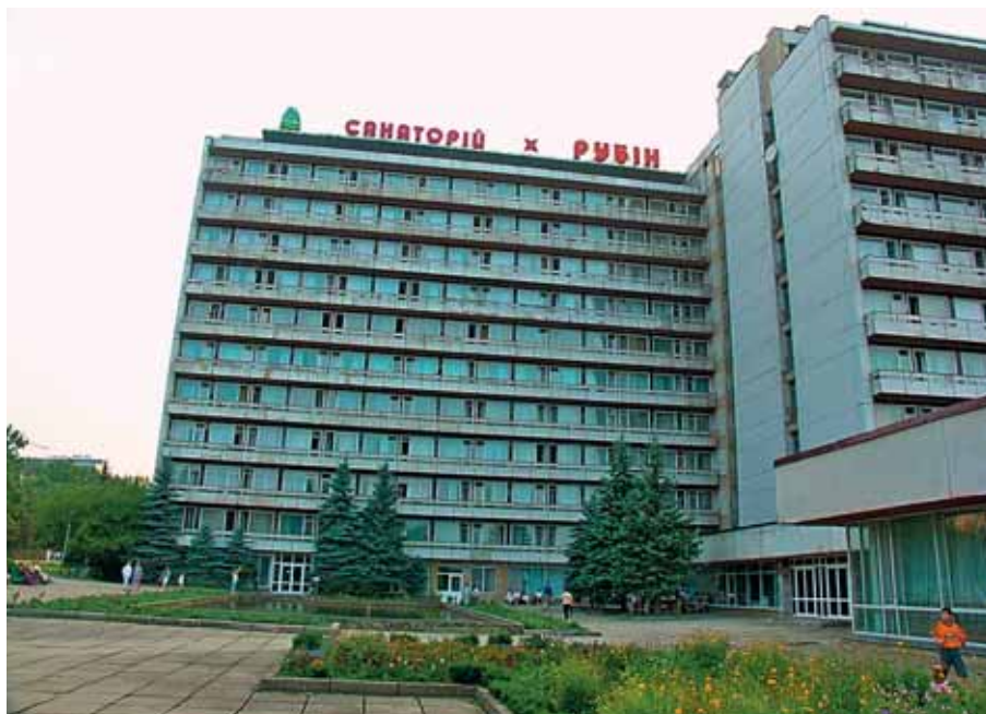
Fot. 3. Truskawiec, południowo część uzdrowiska. Sanatorium Rubin (1980 r.)
