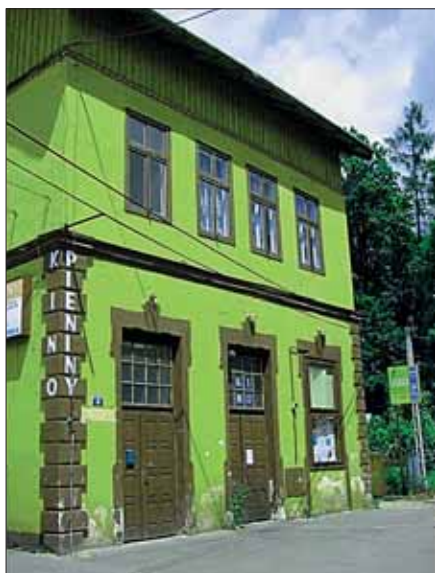
Obecny stan budynku
